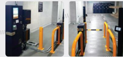
ゲート式駐輪場システムの出入口。ICカードをかざして入退場する仕組みとなっています。
